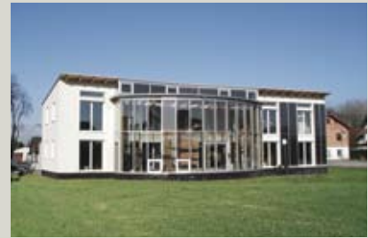
Sent Pantaleon / Austrija Fasadna termoizolacija: Austrotherm EPS® AF PLUS (sivi „stiropor“), d = 35cm (!)
