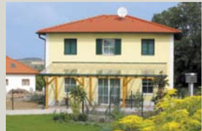
Ebendorf / Austrija Fasadna termoizolacija: Austrotherm EPS® AF PLUS (sivi „stiropor“), d = 30cm (!)
