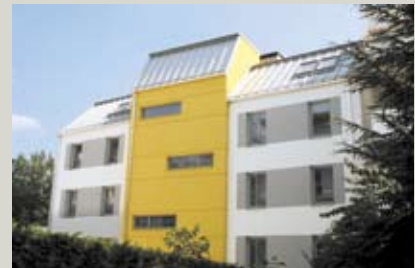
Beč-Pencing / Austrija Fasadna termoizolacija: Austrotherm EPS® AF PLUS (sivi „stiropor“), d = 27cm (!)
