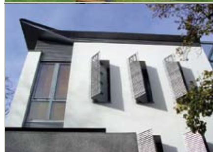
Stambena zgrada u ulici Nike Spasić, Beograd
