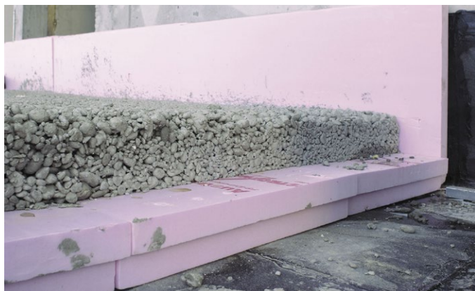
Postavljanje termoizolacije ispod temeljne ploče
