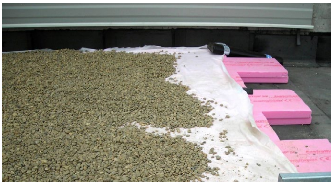
Postavljanje termoizolacije na ravan krov
