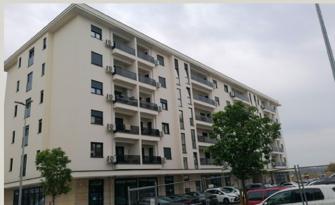
Stambeni kompleks „Acton“, Podgorica. Fasadni izolacioni sistem „Austrotherm & Baumit“ debljine 10 cm.
