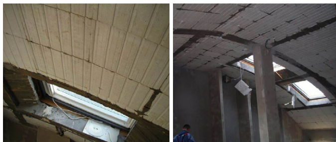
Primena Austrotherm AMK na lučnoj krovnoj konstrukciji
