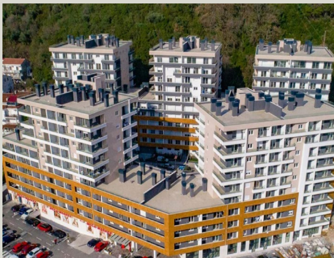
Stambeni kompleks „Old Bakery“, Budva. Fasadni izolacioni sistem „Austrotherm & Baumit“ debljine 10 cm.
