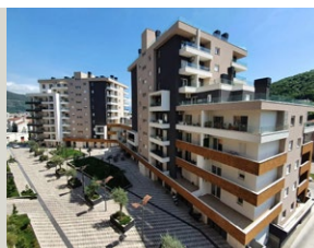
Stambeni kompleks „Old Bakery“, Budva. Fasadni izolacioni sistem „Austrotherm & Baumit“ debljine 10 cm.
