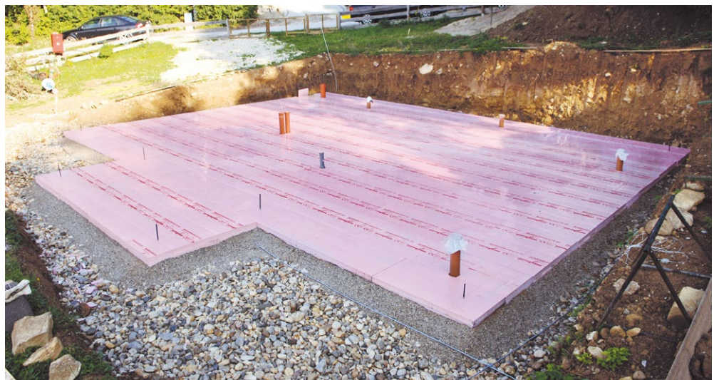
Postavljanje Austrotherm XPS termoizolacije ispod temeljne ploče
