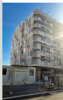
Stambeni kompleks „Acton“, Podgorica. Fasadni izolacioni sistem „Austrotherm & Baumit“ debljine 10 cm.
