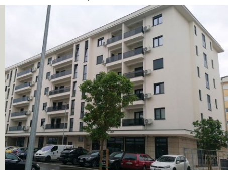
Stambeni kompleks „Acton“, Podgorica. Fasadni izolacioni sistem „Austrotherm & Baumit“ debljine 10 cm.
