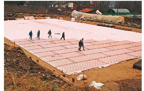
Postavljanje Austrotherm XPS termoizolacije ispod temeljne ploče
