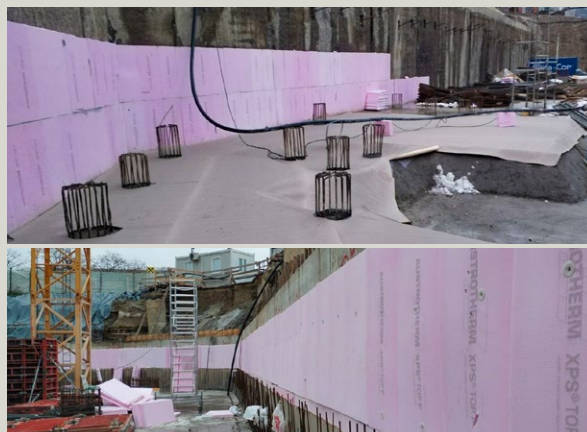
„West Gate“, Novi Beograd | Izvođač: Beeroofing d.o.o.
