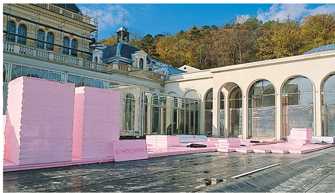
Postavljanje XPS ploča preko bitumenske parne brane
