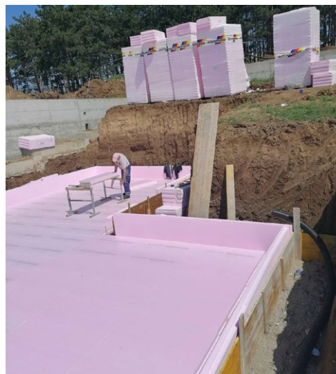
Postavljanje Austrotherm XPS-a ispod temeljne ploče
