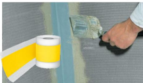
Preko "dihtujuće trake" (Murexin DB 70) izravnjavate površinu špahtl-masom. Podloga postaje idealno glatka i njena priprema je završena!
