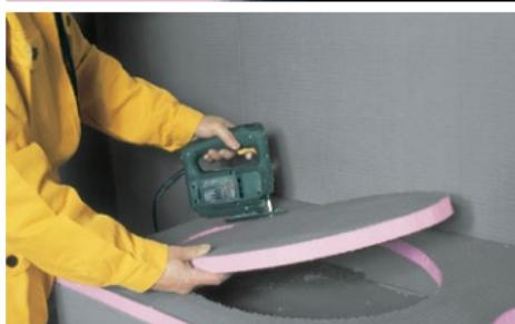
Odgovarajućom testerom možete napraviti najrazličitije forme i oblike iz ploče **Astrotherm UNIPLATTE®**, uključujući i one kružne i ovalne.
