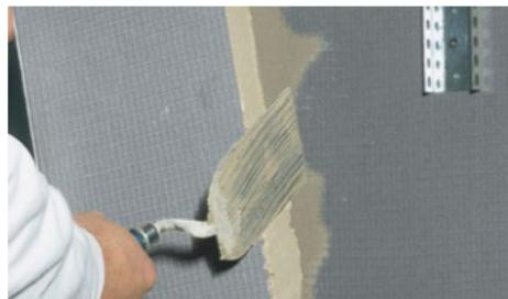
Odmah zatim postavljate ploču **Astrotherm UNIPLATTE®** u ležišta spojnica i na taj način biva odmah fiksirana. Prav ugao ( $90^\circ$ ) je zahvaljujući spojnici zagarantovan.
