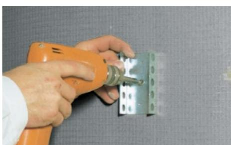
Pri izradi pregradnih zidova, oblagajućih elemenata za kade itd. kao pomoćna sredstva pri montaži koriste se tzv. priključne spojnice. One se šrafe na zid ili pod.
