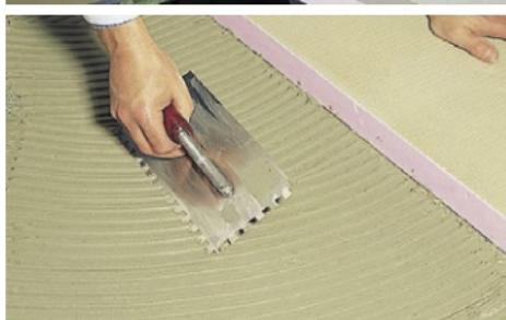
Lepak perfektno prijanja - bez obzira da li je podloga estrih ("košuljica") ili beton. Ukoliko podloga nije noseća, onda se **Astrotherm UNIPLATTE®** mora tiplovima pričvrstiti za nju.
